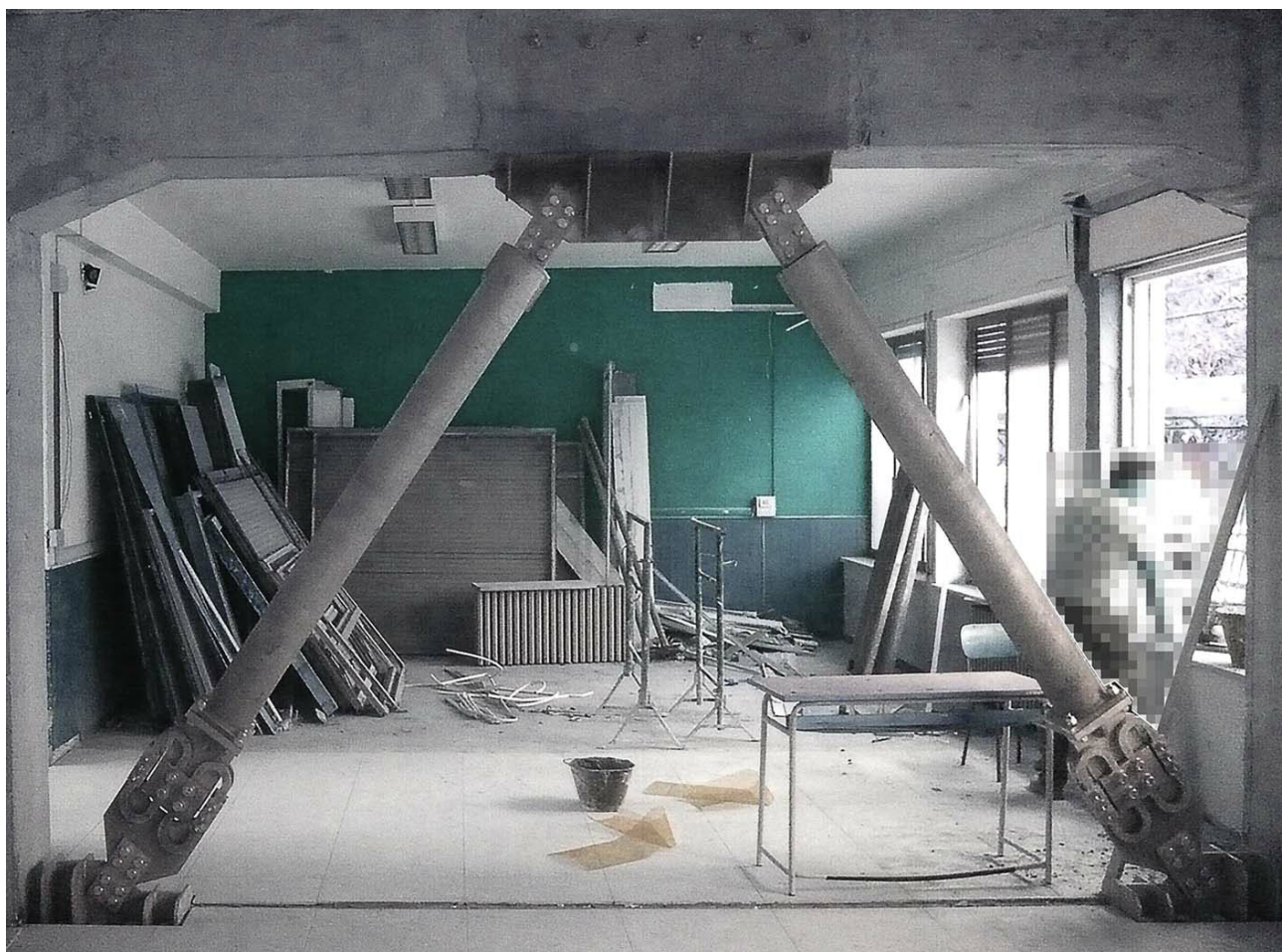
Installazione di controventi dissipativi
